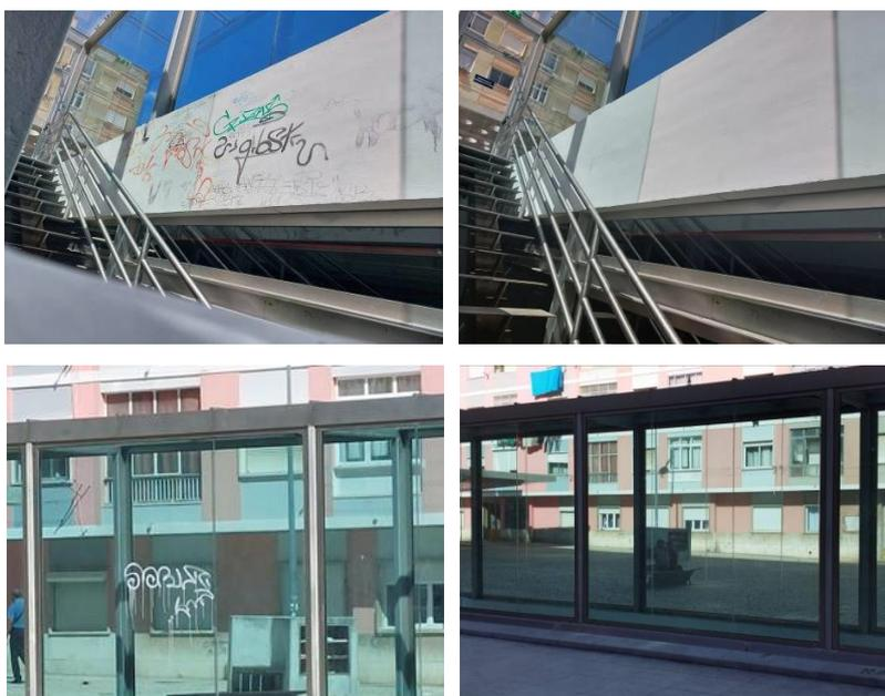
Figura 27: Limpeza de *graffiti* da parede e vidros
