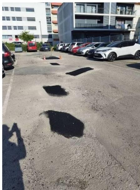
Figura 18: Obras de reparação realizadas na Zona 117 de Loures (após a intervenção)
